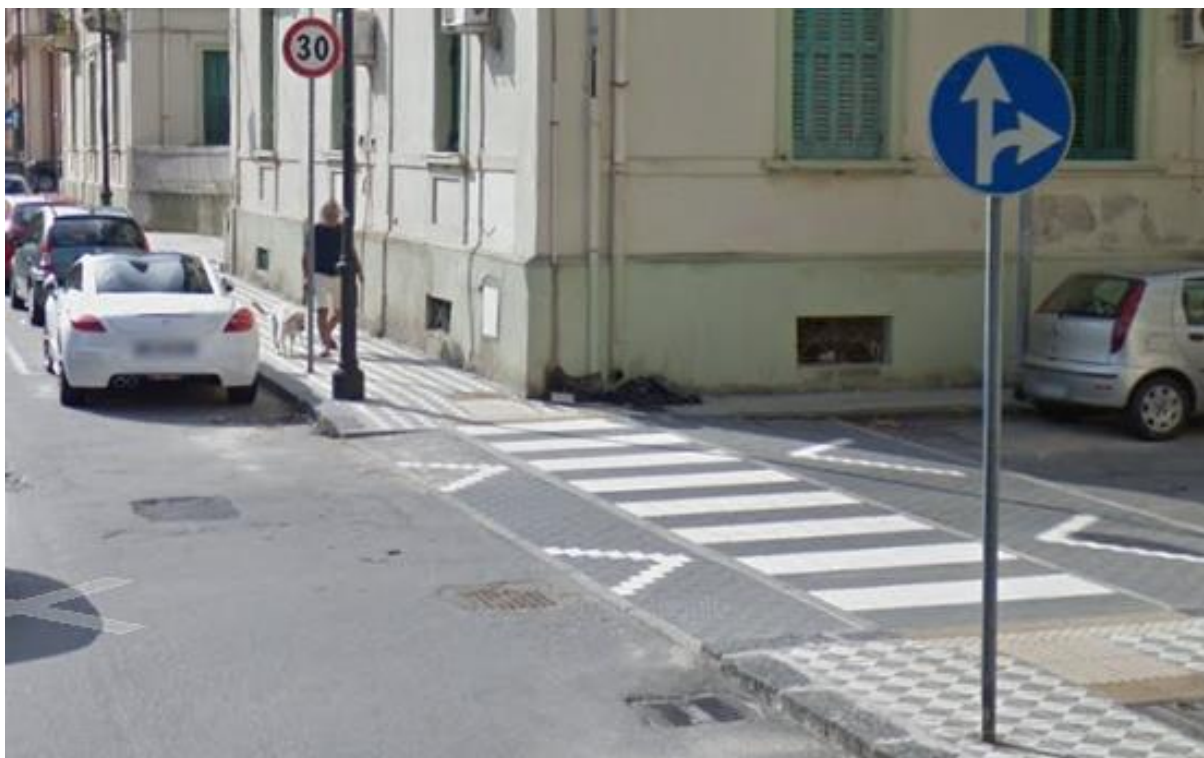
Figura 22 – Esempio di Attraversamento pedonale rialzato (via Marconi, Villa S.G.)
